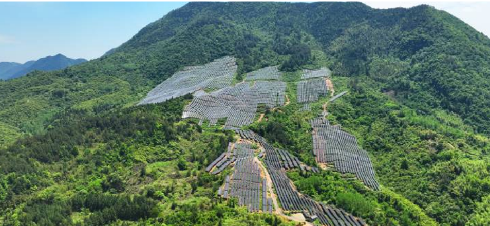
▲ 浙江省衢州市衢江区上方镇4MW山地光伏项目
