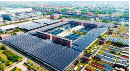
上海城投竹园污水分公司二期8.18MW 分布式光伏发电项目
