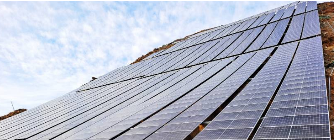
▲ 山西华电应县风光储一体化融合发展工程光伏项目
