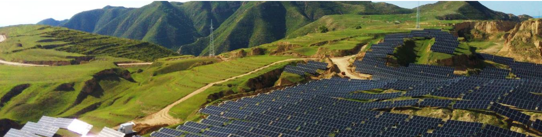
大唐阳原西区50MW风电和100MW光伏及升压站工程项目 ▲
