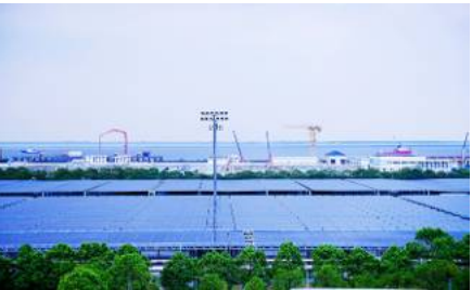
上海白龙港污水处理厂11.75MW 分布式光伏发电项目柔性支架工程
