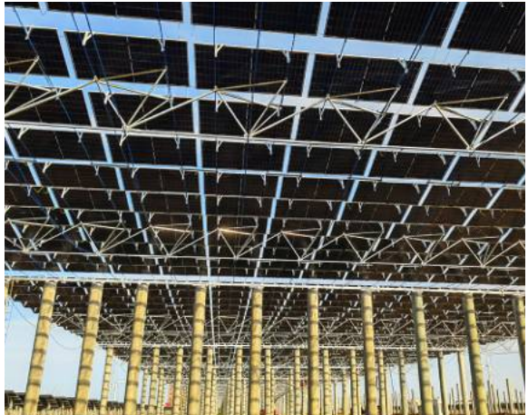
▲ 射阳盐场100MW农(渔)光互补项目 一期柔性支架光伏发电项目
