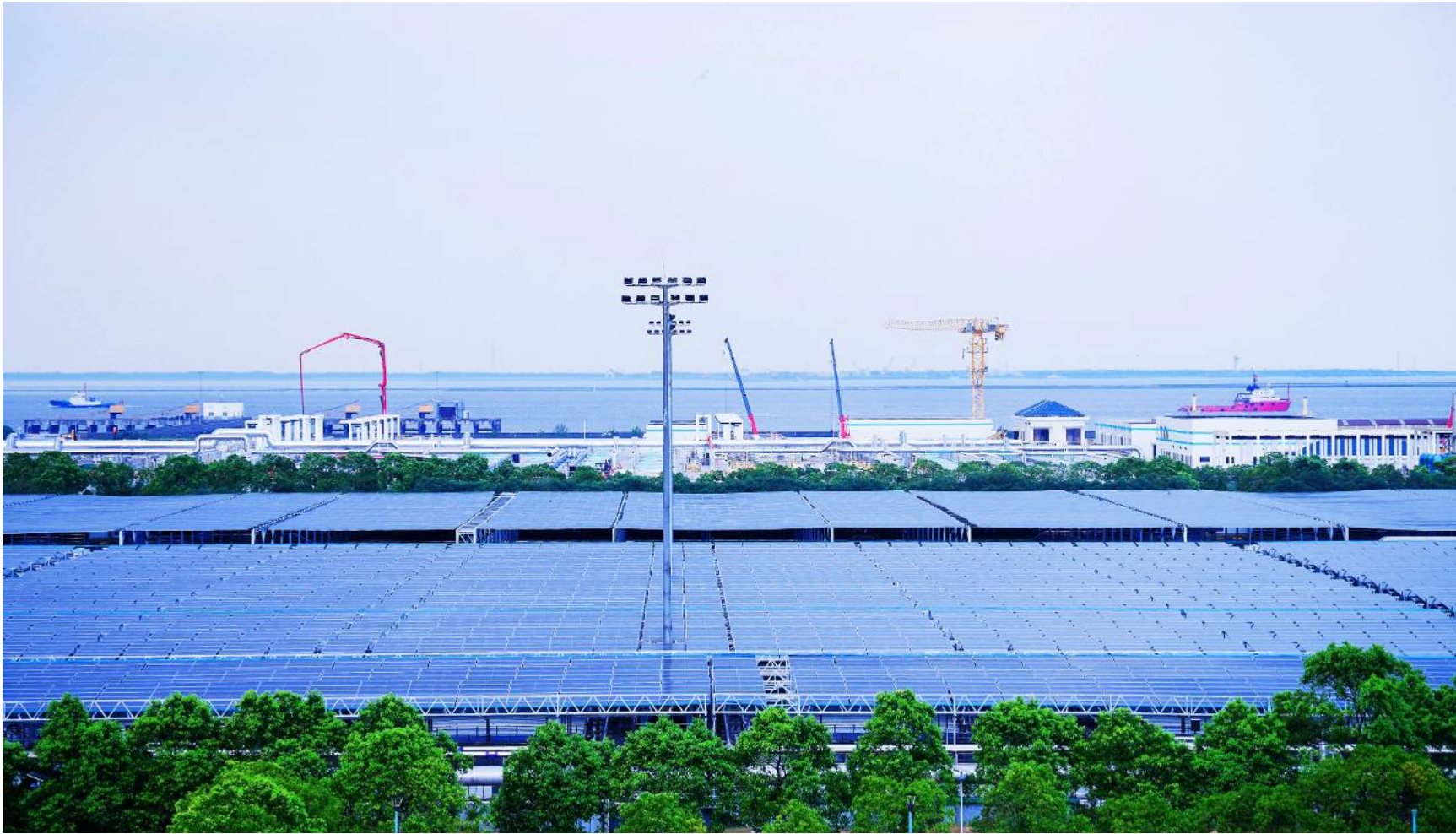
▲ 上海白龙港污水处理厂11.75MW分布式光伏发电项目柔性支架工程
