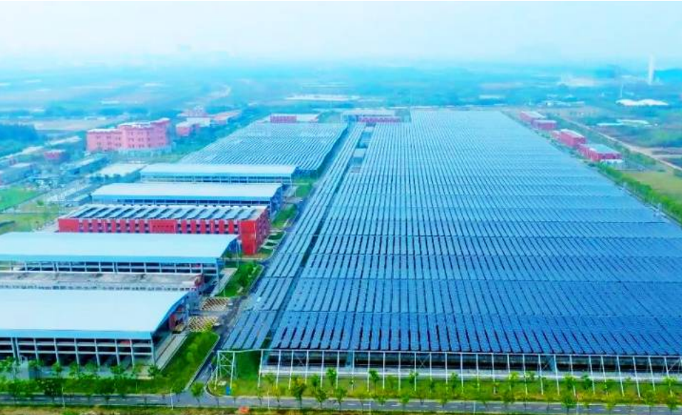
▲ 北湖污水处理厂23.7MW分布式光伏发电项目
