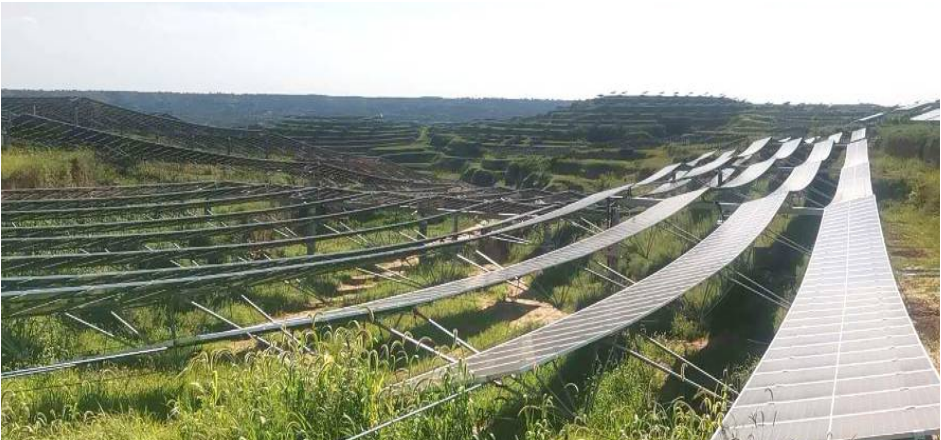
▲ 渭南合阳光伏发电项目柔性支架EPC总承包项目
