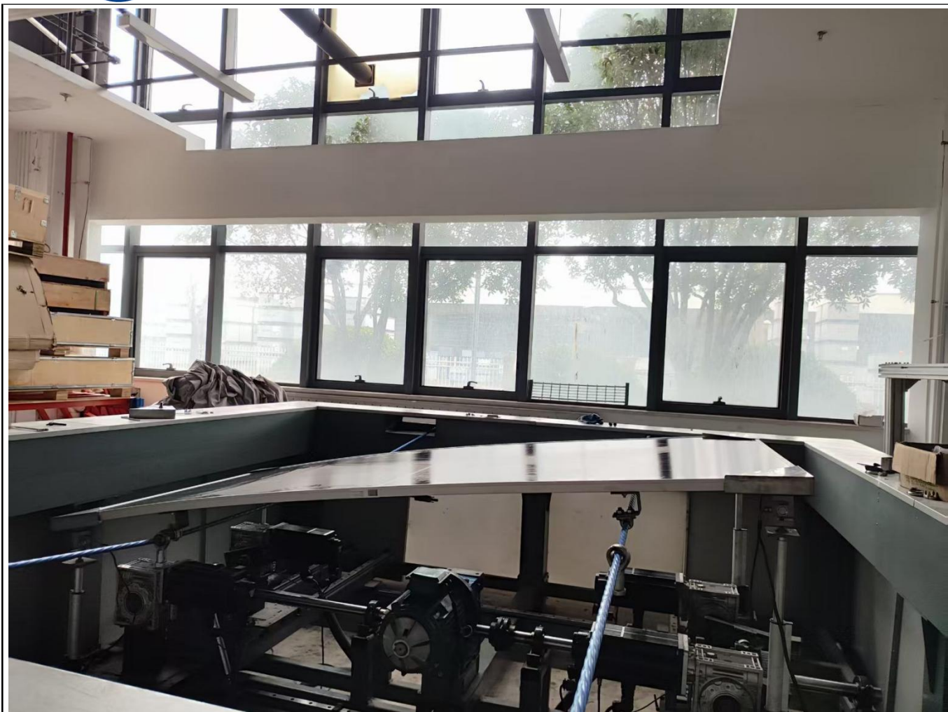
静态梯形载荷测试安装照 1
